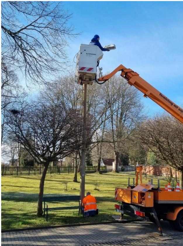
Abbildung 4: Austausch eines kompletten Lampenschirmes
